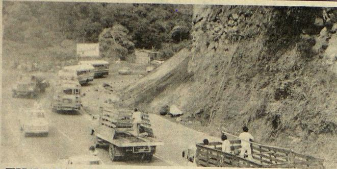
**CERRARAN EL PASO.** En este punto del Km. 19 de "La Cuchilla", carretera a Occidente, se efectuarán trabajos de demolición de un conjunto rocoso que amenaza derrumbarse. Para evitar desgracias, será dinamitado y se bajará un talud en una altura aproximada de 45 metros. La obra la realizan trabajadores de la 2a. Zona de Caminos con sede en Santa Tecla.
