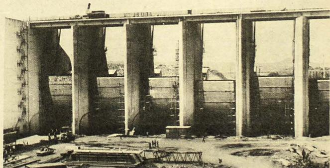
**VERTEDERO.** Vista parcial del vertedero de la central hidroeléctrica de San Lorenzo, que construye la CEL en el Río Lempa. Se aprecia la magnitud de pilares y computuertas, por comparación con la figura humana. La obra física ha alcanzado un avance de
