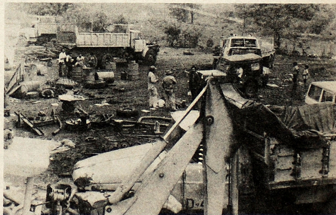
DESTRUCCION (Zacatecoluca). Grupos extremistas destruyeron el sábado en el Cantón San Rafael de esta jurisdicción parte de la maquinaria de la empresa construc-
