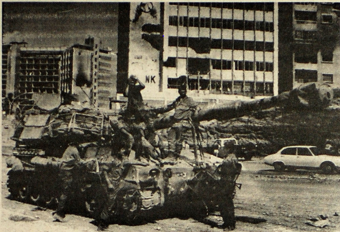
MANTIENEN VIGILANCIA. — Beirut, octubre 23. Soldados israelíes, a bordo de un tanque, mantienen una constante vigilancia en el oeste de Beirut. Al fondo, edificios dañados por la artillería. (UNIFAX II de UPI).
