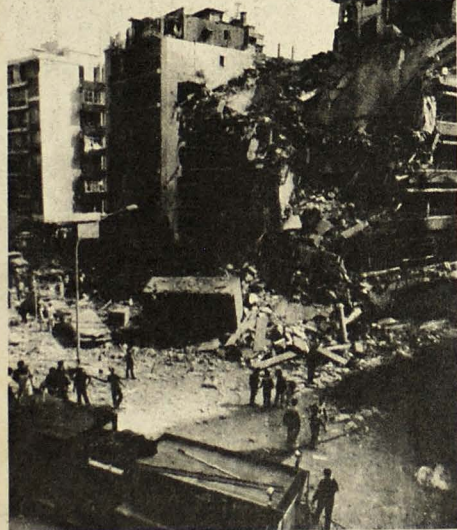
EDIFICIOS DESTRUIDOS. — Beirut, julio 27. Los habitantes de los edificios destruidos por bombardeos israelíes, observan las ruinas de los mismos. Centenares de personas murieron y fueron heridas en la zona residencial de Raouche. (UNIFAX II de UPI).
