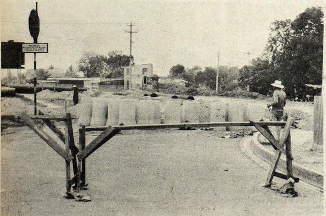
**TRABAJOS OBSTACULIZAN TRANSITO.**— En el redondel de la colonia Miravalles, de esta capital, se realizan trabajos de instalación de tuberías para alcantarillados. Los tubos han sido colocados en plena calle y obstaculizan el paso de los vehículos automotores.
