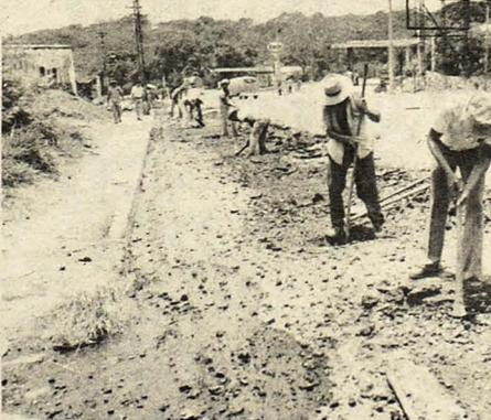
**OBRAS DE NUEVO TRAMO AUTOPISTA. Empleados de ANDA trabajan en la colocación de tuberías y drenajes previos a la construcción del tramo Santa Ana-Metapán, correspondiente a la autopista San Salvador-Santa Ana-Metapán. Los trabajos se realizan a la altura del kilómetro 64, de la "Calle Vleja" a la Ciudad Heroica.**
