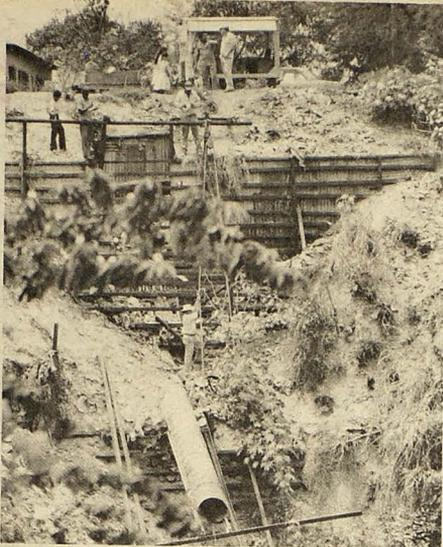
**TRABAJOS DE MANTENIMIENTO.**— Obreros de FENADESAL se encuentran trabajando en la construcción de muros de contención en un barranco de unos 15 metros de alto en la Colonia Cuzcatlán, de Ciudad Delgado. Los trabajos son agilizados, ya que en invierno las aguas lluvias erosionan el terreno y la línea férrea pasa a unos 3 metros de la barranca.
