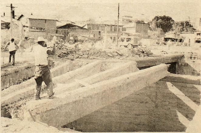
**AVANZAN TRABAJOS DE BOVEDA.**— Los trabajos de construcción de una bóveda en el moderno puente de La Vega, se encuentran avanzados. Los realiza el Ministerio de Obras Públicas. En dicho lugar se construirá un paso a dos niveles, para dar mayor fluidez al movimiento de vehículos automotores en ese sector capitalino.
