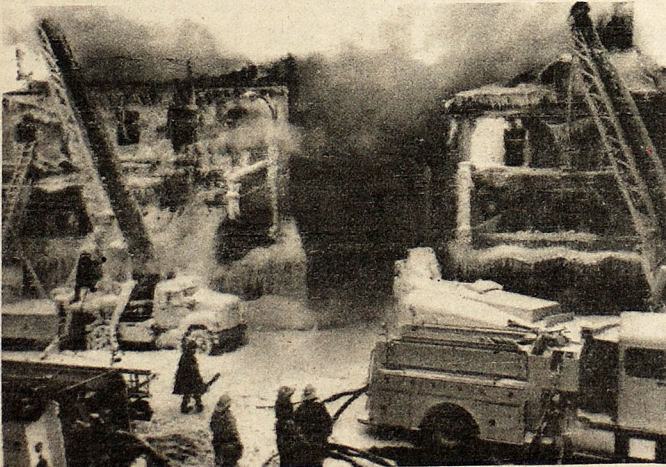
VORAZ INCENDIO.— Quebec, Canadá, enero 25. Al menos seis edificios, en la antigua zona histórica de la ciudad, fueron dañados hoy por un voraz incendio, el mayor en 15 años.
