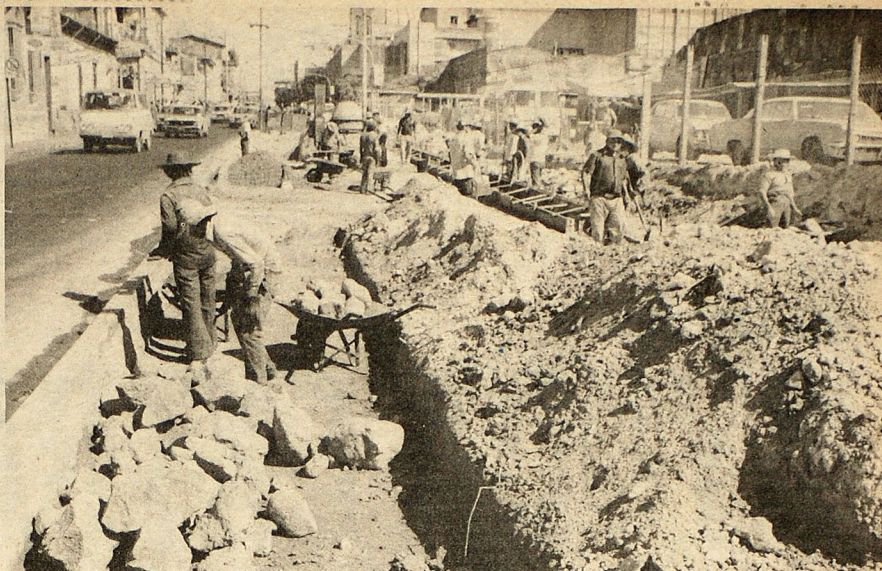
AMPLIAN AVENIDA. — La demolición de casas antiguas en Avenida Cuscatlán, en esta capital, ha permitido que los trabajadores de Obras Públicas inicien las obras de ampliación de esa importante arteria. Se espera que esa avenida no sea utilizada para zona de estacionamiento como se acostumbra cuando se amplían las calles.
