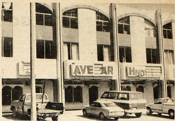
DAÑOS POR ONDAS EXPANSIVAS. — El Condominio Cuscatlán, que se encuentra frente a la "Casa del Repuesto", sufrió daños materiales por la explosión de un artefacto dinamitero colocado por terroristas. Se condena esta clase de atentados que siguen dañando la economía del país.
