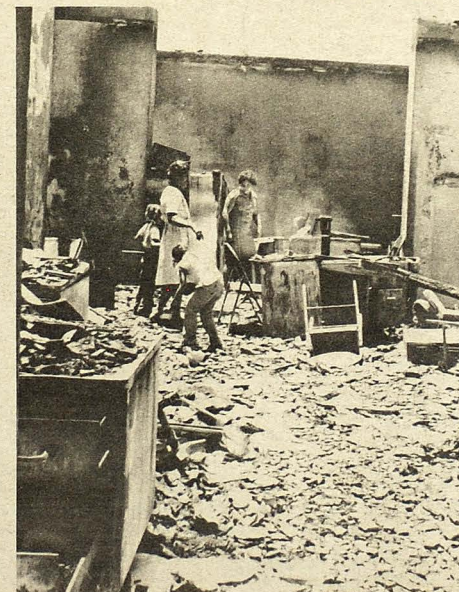
ALCALDIA DESTRUIDA. Cuantiosos daños materiales dejaron elementos extremistas al originar un incendio que destruyó totalmente la Alcaldía Municipal de Apopa.
