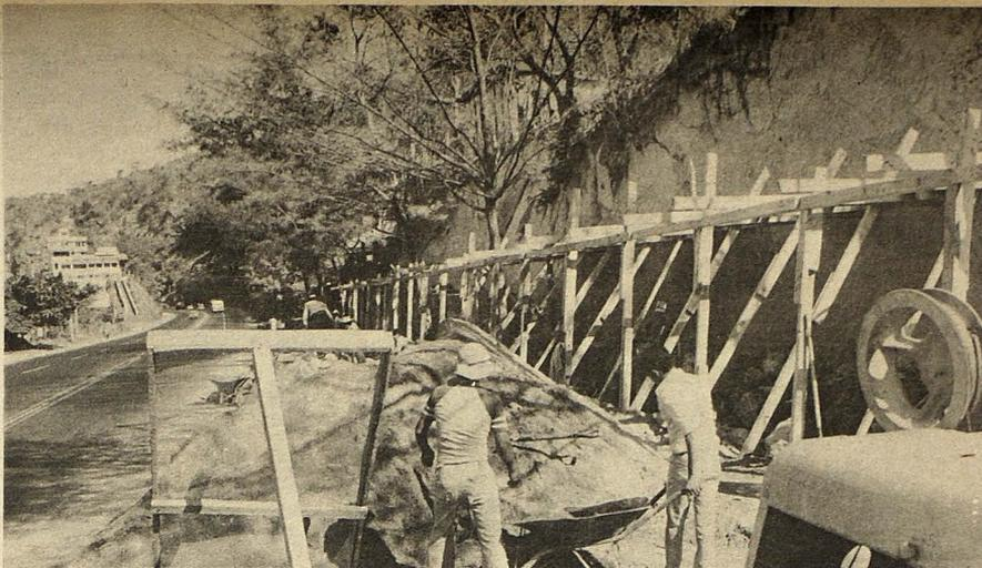
**CONSTRUYEN MURO.**— Un muro de contención de 109 metros de longitud, levantan en el lado exterior del balneario Los Chorrros, dentro de las obras de remodelación que realiza el ISTU. También se lleva a cabo la construcción de nuevos desvestideros y caseta de control. Los trabajos estarán concluidos en abril.
