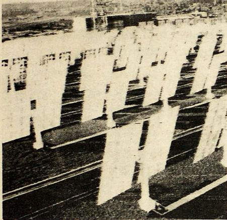
PLANTA EURELIOS. Adriano, Italia, febrero 9 (AP). Vista de la planta Eurelios, productora de electricidad a partir de la energía solar. Ciento ochenta y dos espejos denominados heliostatos captan los rayos solares y los dirigen hacia la torre que se ve al fondo, que a su vez los transforma en electricidad. La planta Eurelios es una empresa conjunta de la Comunidad Europea, Italia, Francia y Alemania Occidental.
