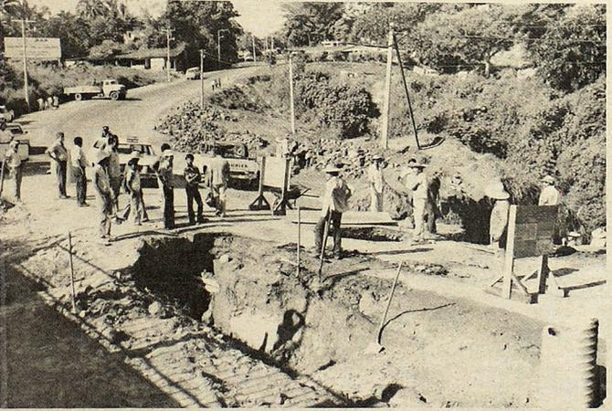
**CARRETERA CORTADA EN DOS.**— Las fuertes lluvias que cayeron anoche en la capital, causaron grandes estragos en la Troncal del Norte, Km. 14 1/2 Col. Bolívar. Las correntadas rompieron tuberías y un muro de contención, que trabajadores de DUA reparan. El paso de vehículos estuvo interrumpido por varias horas y sólo se podía transitar por el final de la calle a Paleca.
