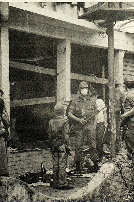
GRANDES DESTROZOS. — El domingo a las 7 y 30 de la noche, elementos terrorista colocaron una bomba de alto poder explosivo en la entrada principal de la venta de muebles Molina Hnos. en la ciudad de Santa Tecla. Los daños son cuantiosos y las pérdidas ascienden a varios miles de colones.
