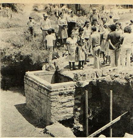
**TRABAJOS DE RETENCION.**— En el kilómetro 14 y medio, de la carretera a San Martín, la comunidad y el personal de PRIDECO están realizando obras de beneficio. Se puede citar la construcción de un muro de retención el cual era de suma necesidad para evitar que el terreno se destruya con el deslave y sea la causa de otros daños. Los trabajos los lleva a cabo bajo el programa de participación que sigue el gobierno. Un grupo de vecinos atiende las indicaciones de los promotores de la institución.
