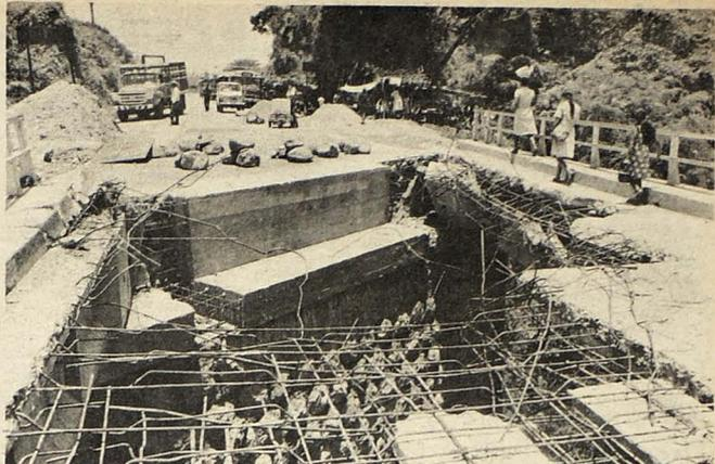
**PUNTE DINAMITADO.**— El Puente Azambó, entre los kilómetros 68 y 69 de la Carretera a Chalatenango, es uno de los que ha sido destruido casi en su 50 por ciento de construcción. Dos bombas hundieron las construcciones de hierro y cemento, obstruyendo una vía de acceso para el comercio entre Chalatenango y San Salvador. Sin embargo, hay un servicio de transbordo de buses junto al puente y los usuarios ya se acostumbraron al cambio de buses, según dicen.
