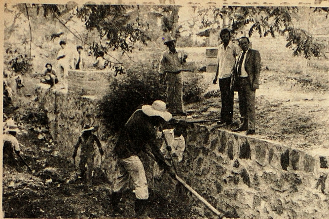
OBSERVAN EJECUCION. — El alcalde capitalino Lic. Julio Adolfo Rey Prendes y el director de PRIDECO, Lic. Saul Guevara, recorrieron los trabajos de ejecución de la Campaña de Limpieza y Saneamiento, que se realizan en el caserío "Las Lajas", de San Antonio Abad. Ambas instituciones, en forma coordinada, instruyen a más de 150 familias sobre cómo deshacerse de la basura.
