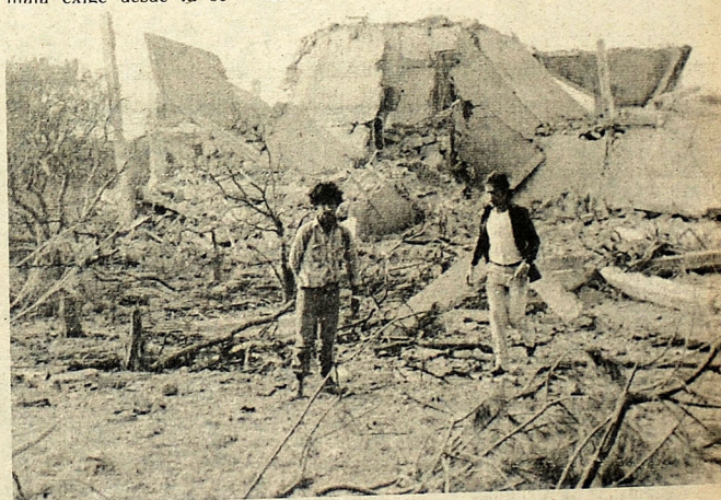
INSPECCION A DESTRUCCION. Abu Al Aswad, Líbano, junio 2.— Un comando palestino se para frente al edificio destruido por aviones israelíes, mientras otro hombre inspecciona los daños sufridos por el edificio. Abu Al Aswad está unos 85 kilómetros al sur de Beirut. (UNIFAX II de UPI).
