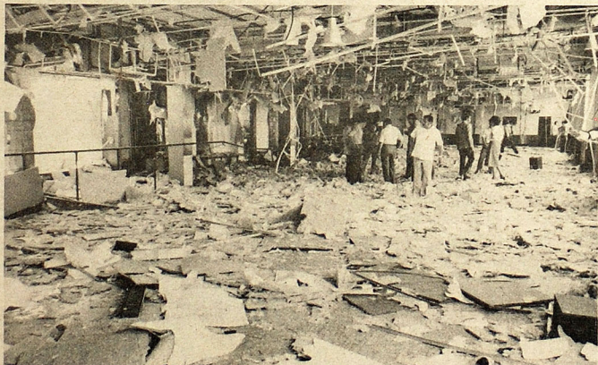
DESTRUYEN PISTA. — La pista de patinaje "Roller Skate", ubicada contiguo al Hotel Alameda, en la 45ª Avenida Sur y 4ª Calle Poniente, de esta capital, fue destruida ayer al mediodía por una bomba terrorista. Los daños causaron pérdidas por varios miles de colones.
