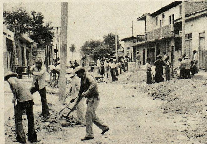
**PAVIMENTACION.**— La DUA realiza trabajos de pavimentación en la 2ª Calle Oriente de Soyapango. Actualmente se coloca la tubería para aguas lluvias en ese sector. La pavimentación se hará en el tramo de 100 metros.
