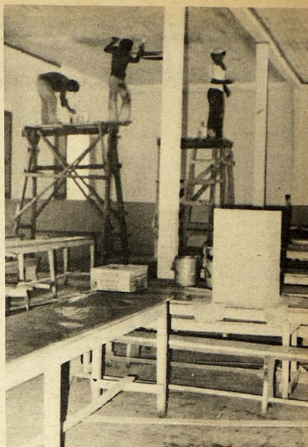
HACEN REPARACIONES. — Trabajos de reparación de techos, paredes, muebles, de pintura y en desagües de aguas lluvias, se llevan a cabo en las instalaciones del Asilo Sara Zaldívar. Se informó que ello dará mayor higiene y comodidad a los ancianos allí atendidos.
