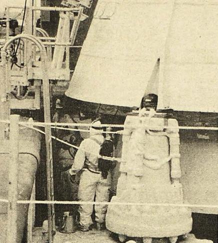
**CORRIGEN DEFECTOS.**— Cabo Cañaveral, Florida, abril 7. Técnicos trabajan para corregir defectos menores en una válvula, que dejaba escapar oxígeno entre la plataforma de lanzamiento y los tanques subterráneos de almacenamiento. El lanzamiento está programado para el viernes 10. (UNIFAX II de UPI).
