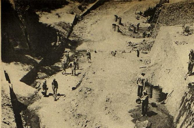
**MUROS DE PROTECCION.**— En la calle a Asino, Ilopango, el Ministerio de Obras Públicas está construyendo muros de protección para que el agua lluvia corra sin problema hasta los colectores de descarga. Además de constituir los trabajos una gran necesidad para evitar las inundaciones, el MOP mantiene a centenares de obreros laborando dentro del Programa de Generación de Empleo.
