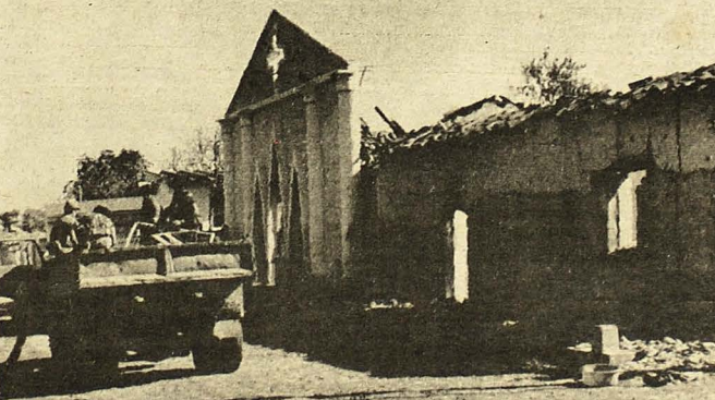
PATRULLAJE. — Una tanqueta circula por una calle desierta de San Lorenzo, San Vicente, donde el Ejército sostuvo batalla contra elementos terroristas del FLMN, que se vieron obligados a desalojar la población. La iglesia del lugar (derecha), quedó destruida a raíz de la lucha.
