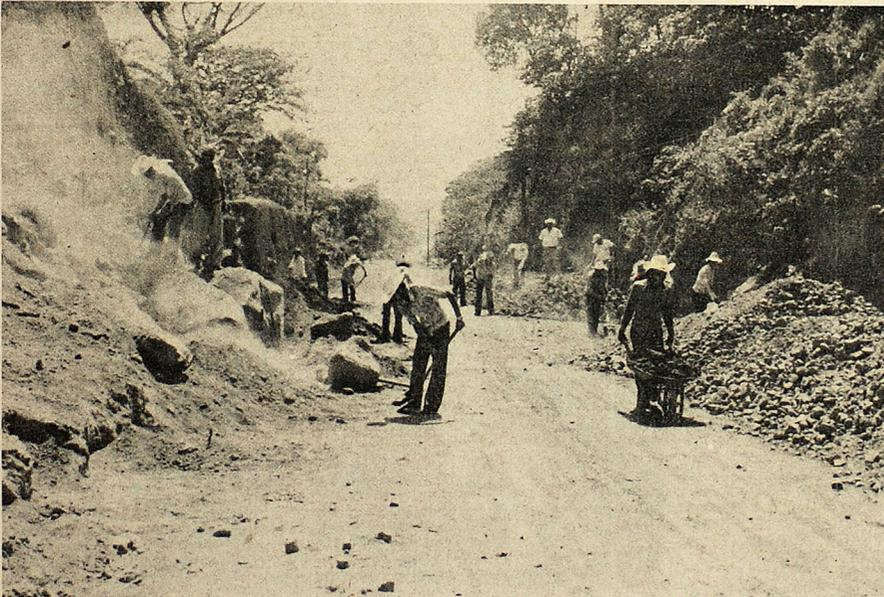
**CARRETERA LOS ARENALES-JUCUAPA.** — Con un proceso de terracería, sub-base, base y obras de drenaje menor, se está construyendo el tramo de carretera de Las Marias-Los Arenales. El tramo tiene una longitud de 4 kilómetros y medio. Cuadrillas de Caminos operan en la obra.
