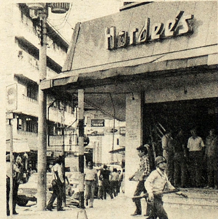
DESTRUCCION. En el Restaurante Hardee's, en la Agencia Ahorromet y en Santa Tecla hubo antenoche detonación de bombas, por grupos desconocidos. Los daños en el Hardee's y en Ahorromet, se calculan en muchos miles de colones. No hubo daños personales.
