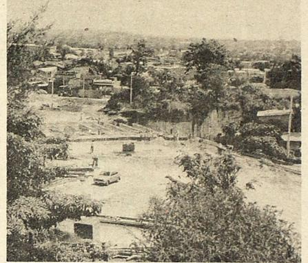
**INICIAN FUNDICIÓN.** Después de colocadas las 16 vigas que sostendrán el puente sobre nivel, en el Boulevard Tutunichapa, se ha dado inicio a la fundición de las mismas con concreto. Luego vendrá el revestimiento con cemento y la colocación de barandales. Debajo pasará la prolongación de la 11a. Avenida Norte, que pasando por el Centro de Gobierno conectará con la 27a. Calle Poniente.
