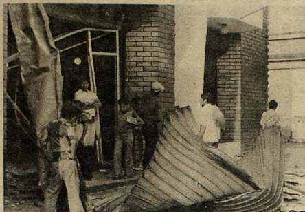
ESTRAGOS. Este es un aspecto de los estragos causados por una bomba detonada el sábado en la madrugada en un restaurante a inmediaciones del Colegio Don Bosco, de esta capital.
