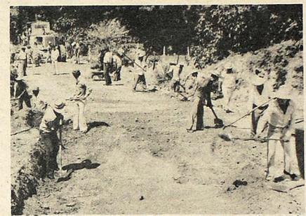
REPARAN VIA. A partir del 8 de septiembre recién pasado se iniciaron los trabajos de reparación de la calle que conduce a Amatitán, en Apulo, informaron funcionarios de la Dirección General de Caminos. La ampliación y reparación consiste en colocación de tuberías de drenaje y compactación de superficie de rodamiento. El tramo de carretera tiene una longitud de 3 kilómetros aproximadamente.
