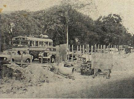
**TRABAJOS EN BOULEVARD.** Avanzadas se encuentran las obras del MOP en el Boulevard del Ejército; los canales construidos en medio de la vía, contarán con amplio sistema para conducción de aguas negras. El tramo citado, consta de varios centenares de metros, para lo cual se han utilizado materiales diversos y mano de obra capacitada.
