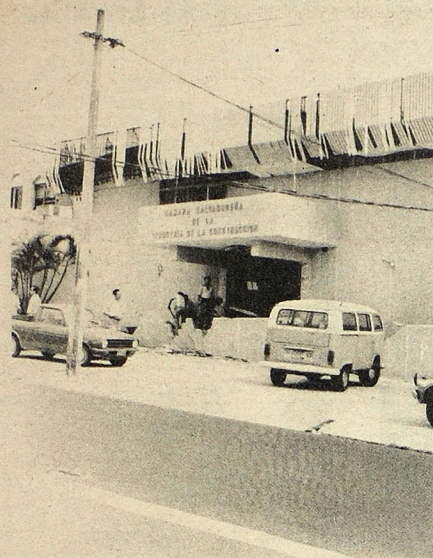
CUANTIOSOS DAÑOS. En la Cámara de la Construcción (izquierda) y Banco de Desarrollo, fueron detonadas bombas que causaron serios daños y la consiguiente alarma
