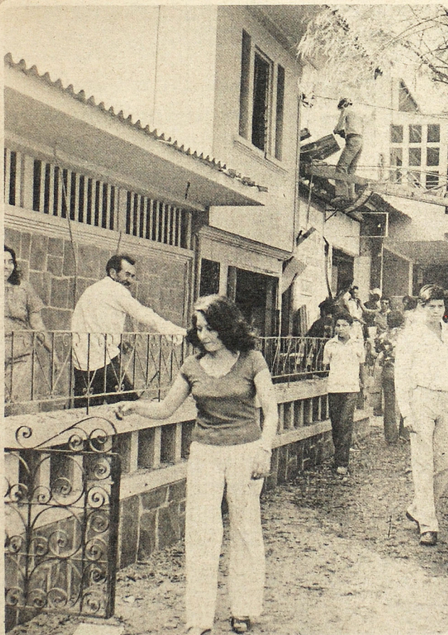
DINAMITAN. —Una explosión de dinamita causó serios daños en el local de la Comisión de Derechos Humanos de El Salvador, situado en la Avenida España No. 928. Hubo daños en mobiliario, equipos de oficina y edificio.
