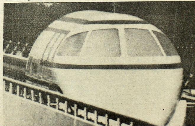
**DESARROLLA ALTA VELOCIDAD.** — Miyazaki, Japón, diciembre 17. Un vehículo de alta velocidad, el MLU-001 “flota” sobre sus rieles en un campo magnético, durante una prueba efectuada aquí. El vehículo alcanzó en la prueba una velocidad de 230 kilómetros por hora. Afirmaron que puede llegar a los 480 kilómetros por hora.
