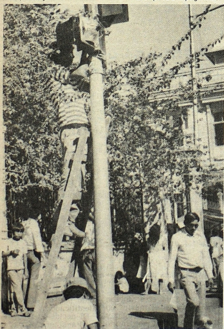
SEMAFORIZACION.— Ha continuado la semaforización en San Salvador. Ayer en la mañana colocaron nuevos semáforos frente al Hospital Rosales, en la entrada principal. En ese sitio fueron instaladas varias unidades, de acuerdo con el plan de las autoridades.
