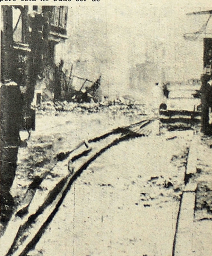
EFFECTOS DE EXPLOSION. — Estambul, septiembre 4. Efectos de la explosión e incendio en que murieron dos personas y fueron destruidos varios edificios. (UNIFAX II de UPI).
