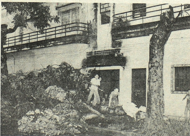
DAÑOS POR TORMENTA. — En la tarde de ayer, una fuerte tormenta azotó San Salvador y alrededores. En varios lugares, los árboles que se desplomaban por el fuerte viento, reventaron algunos cables de la luz eléctrica y el servicio estuvo interrumpido por varias horas.
