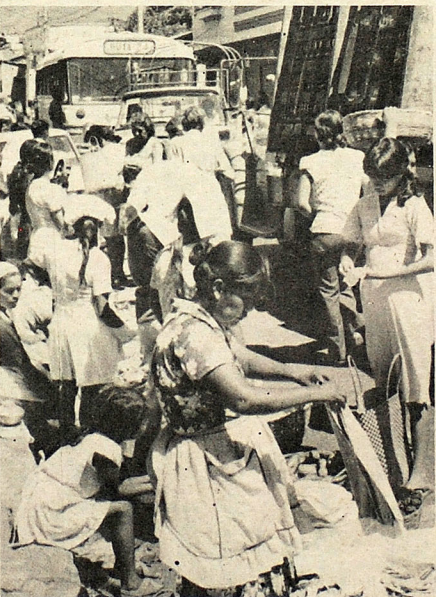
CIERRAN PASO. — La Municipalidad de Mejicanos ha obstruido el paso de los vehículos en la entrada a esa ciudad, por la segunda Avenida Norte, con dirección hacia el mercado. El cierre se debe a que se realizan trabajos para construir una galería para las damificadas del mercado. Los automovilistas encuentran serios problemas para ingresar por la falta de señales o la cooperación de una policía municipal.
