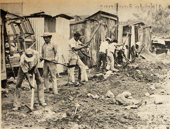
MANOS A LA OBRA. — Decenas de personas han sido contratadas por el Ministerio de Obras Públicas, para realizar los trabajos de limpieza y terracería en el sitio donde se levantará la galera para reubicar a las vendedoras damnificadas del incendio del mercado de Mejicanos. Unas docientas comerciantes serán instaladas allí mientras se construye la otra etapa del mercado. Además de la mano de obra, el MOP ha puesto a trabajar maquinaria pesada para apresurar la labor.
