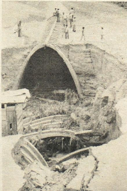
**SE DERRUMBA BOVEDA.**— A causa de la fuerte tormenta que ayer en la madrugada azotó a la capital se derrumbó una bóveda que se estaba construyendo en la colonia Roma, cerca de ANTEL. Las máquinas quedaron bajo el túnel. Hubo desbordamientos en otros lugares de la capital.
