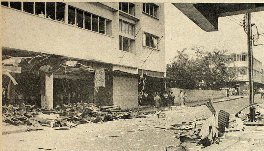
DAÑOS EN CAPITALIZADOR. — Una de las tantas bombas estalladas en la madrugada de ayer, destrozó la entrada principal al costado norte del Banco Capitalizador, Oficinas Centrales, situadas entre la 1ª Calle Poniente y 7ª Avenida Norte. La fuerte explosión dañó asimismo los negocios ubicados en los edificios contiguos y los de enfrente, dejando gran cantidad de vidrios rotos y láminas en la calle, lo cual interrumpió por algunas horas el tránsito.
