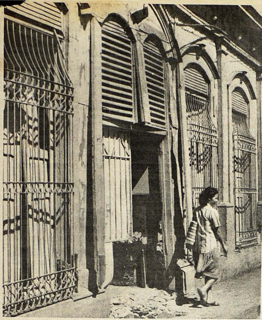
BOMBA EN SINDICATO. — Ayer a la una de la madrugada estalló una bomba de alto poder explosivo en el local del Sindicato de Trabajadores de Gaseosas y conexos. Los sindicalistas anunciaron "que realizarán huelgas a partir de hoy, como protesta". Manifestaron que "hoy entran en huelga los trabajadores de La Constancia".
