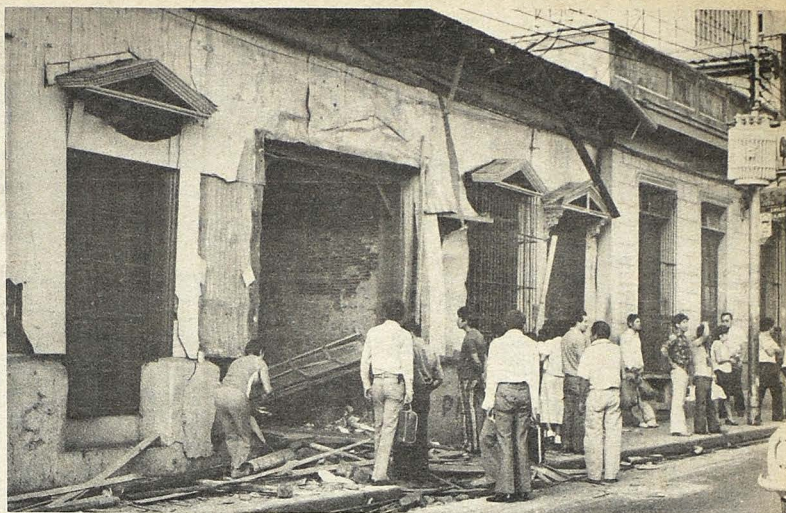
BOMBA EN UN SINDICATO. — Una poderosa bomba fue detonada ayer a las dos de la madrugada en el local de la Federación Sindical Revolucionaria, situado en 3ª Calle Oriente, entre 4ª y 6ª Avenida Norte, de esta capital. La detonación causó graves destrozos en el sindicato y en casas contiguas. No hubo daños personales.
