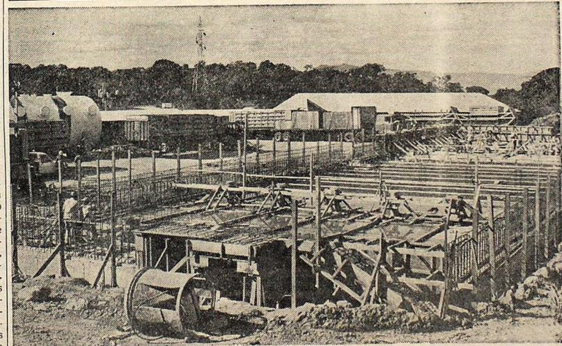
**TORRE DE ENFRIAMIENTO.** Bastante adelantados se hallan los trabajos de instalación de la "Torre de Enfriamiento" de la tercera unidad de la Central Geotérmica de Ahuachapán, que habrá de alcanzar una capacidad estimada de 90 mil kilovatios. La Comisión Ejecutiva Hidroeléctrica del
