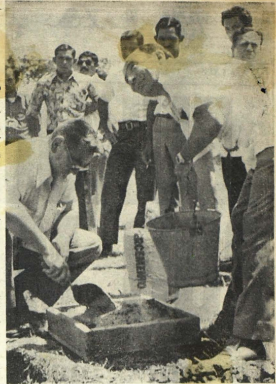
PRIMERA PIEDRA. (San Miguel). A un costo de más de 650 mil colones se construirá el edificio de aulas del Centro Universitario de Oriente, en esta ciudad. El director de la institución, doctor Oscar G. López (agachado), coloca la primera piedra de las edificaciones. Cubrirán un área de 1.100 metros cuadrados.
