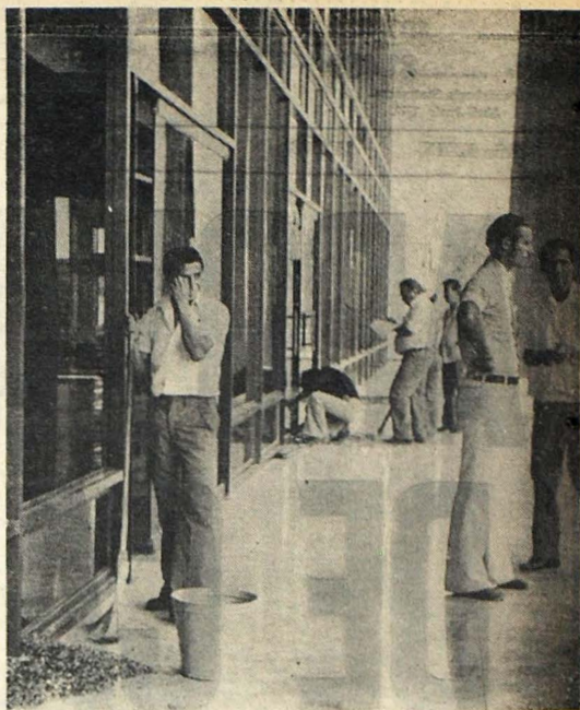
EDIFICIO DAÑADO. Varias ventanas del edificio de la Corte Suprema de Justicia, fueron rotas por los balazos que hicieron varios hombres de una distancia de más de cien metros. También fueron dañados muebles. Empleados limpian la segunda planta.
