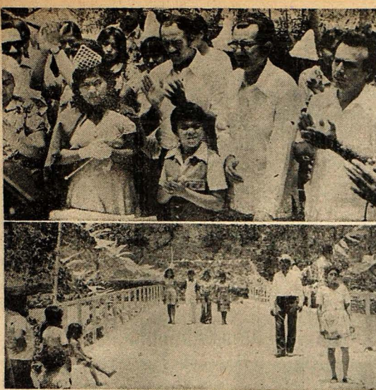
—Foto de LA PRENSA, por Flores G. INAUGURACION. Autoridades de Obras Públicas y del ramo del Interior inauguraron el sábado el puente en el cantón "Calle Real", cuyo costo fue de ochenta mil colones. La obra que beneficiará a cerca de 15 mil personas, fue realizada con el aporte de la comunidad y de FOCCO. Arriba, de izquierda a derecha: Arq. Pío Salomón Rosales, subsecretario del MOP; ingeniero Manuey A. Novoa, director de FOCCO y doctor Luis Sansivirini, gobernador.
