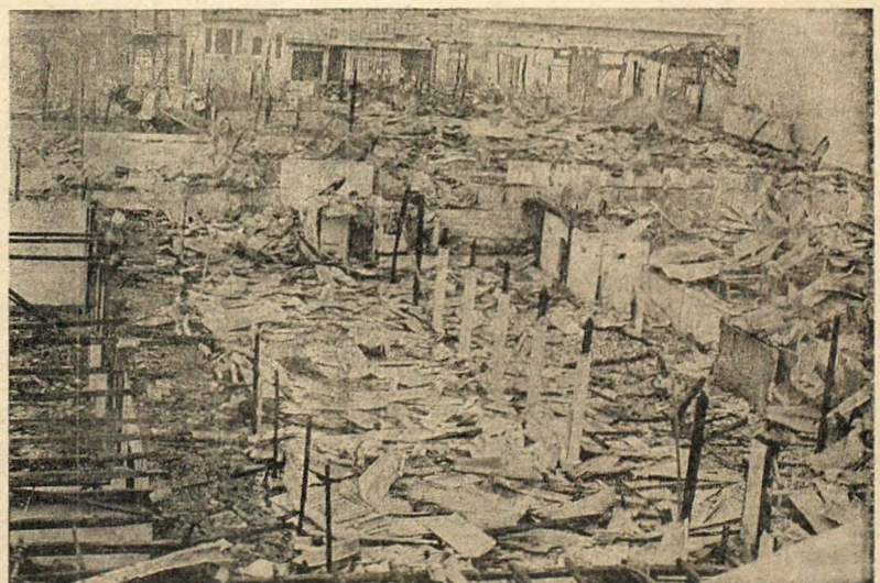
ESCOMBROS. Esta fotografía muestra parcialmente los daños dejados por un incendio antenoche y madrugada de ayer en céntrico sector de la capital, donde varios establecimientos comerciales fueron destruidos por el siniestro. Según el informe oficial, el fuego comenzó a causa de un cortocircuito.
